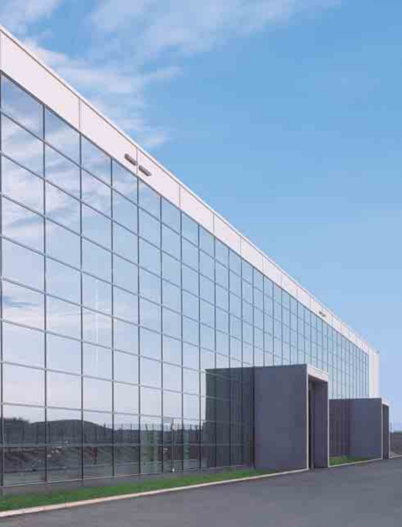
In den Werkshallen der Airbus Air-cabin GmbH werden Ausstattungselemente für Airbus-Flugzeugkabinen gefertigt.
