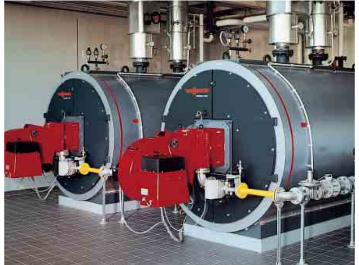
Zwei Großkessel Vitomax 200 mit einer Leistung von je 2,25 MW sorgen für Wärme.
