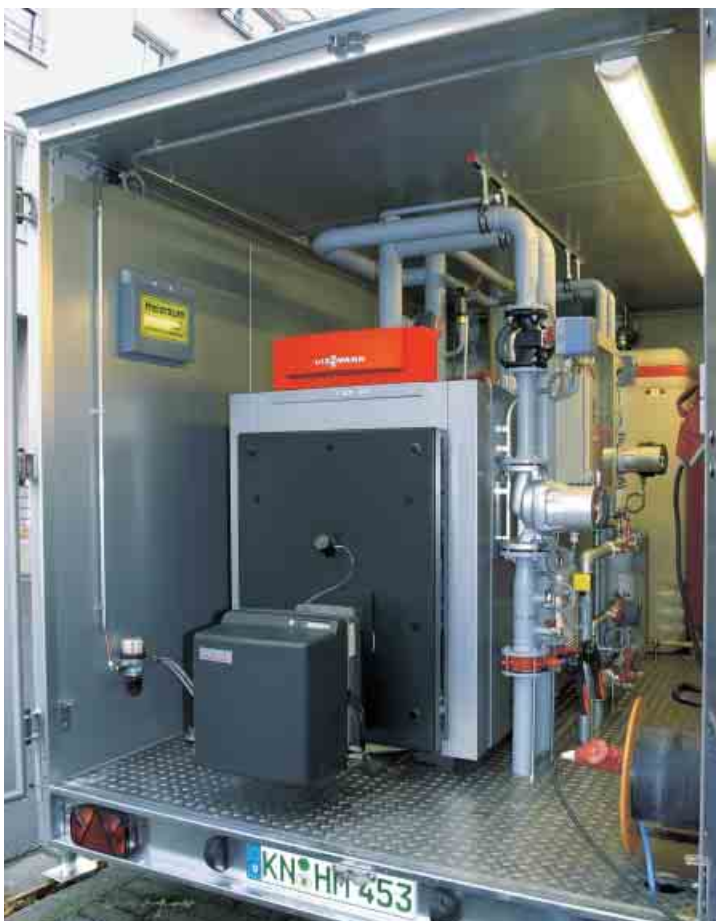
In der mobilen Heizzentrale verrichtet ein Viessmann Mittelkessel Vitoplex 100 seinen Dienst (links). Oben: Künftig sorgt ein Gas-Brennwertkessel Vitocrossal 300 mit einer Leistung von 635 kW für Wärme und niedrige Heizkostenrechnungen im Altenwohnheim.
