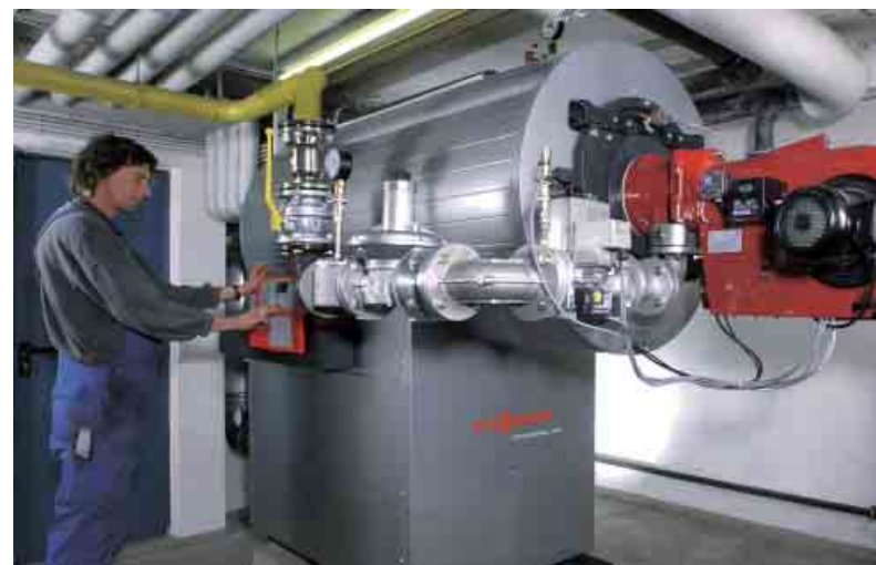
In der mobilen Heizzentrale verrichtet ein Viessmann Mittelkessel Vitoplex 100 seinen Dienst (links). Oben: Künftig sorgt ein Gas-Brennwertkessel Vitocrossal 300 mit einer Leistung von 635 kW für Wärme und niedrige Heizkostenrechnungen im Altenwohnheim.
